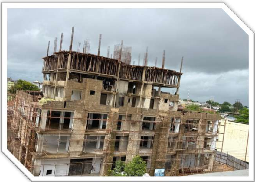
Mradi wa ujenzi wa jengo la biashara katika eneo la Mkwakwani mkoani Tanga (Mkwakwani Commercial Complex)
