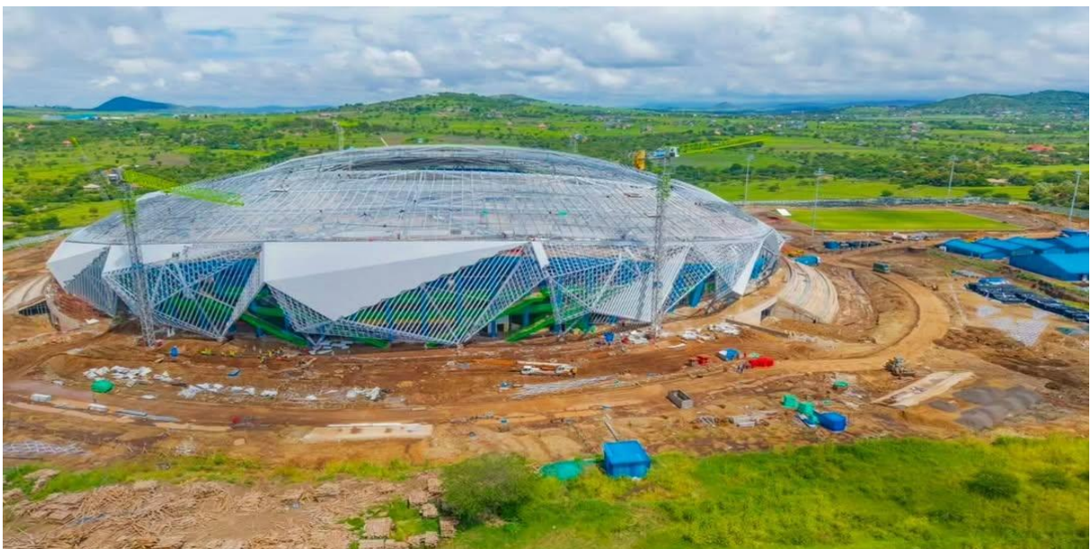
Ujenzi wa uwanja wa Mpira wa Miguu Arusha ukiendelea, Aprili 2026
