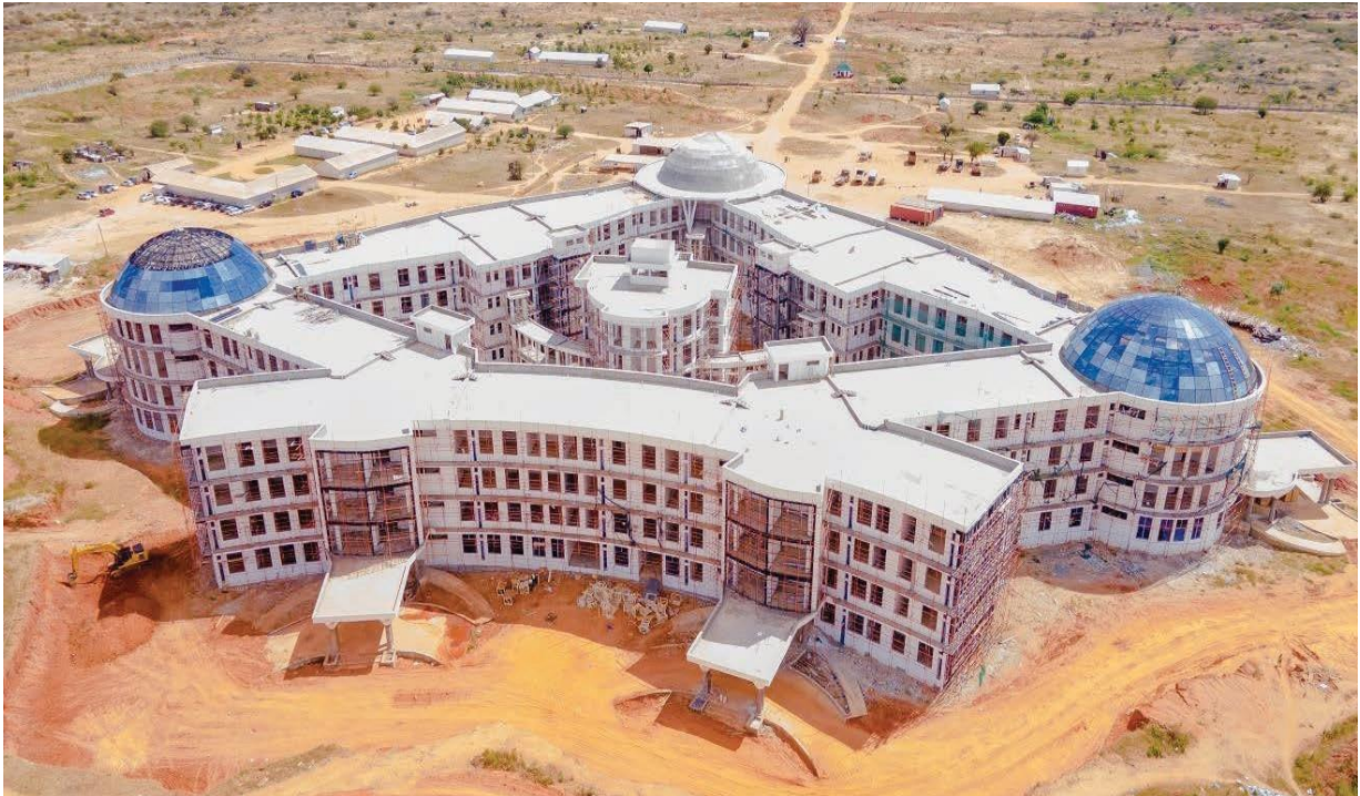
Jengo la Makao Makuu ya Ulinzi wa Taifa (MMUT) lililopo katika hatua za mwisho za ujenzi eneo la Kikombo, Jijini Dodoma.
