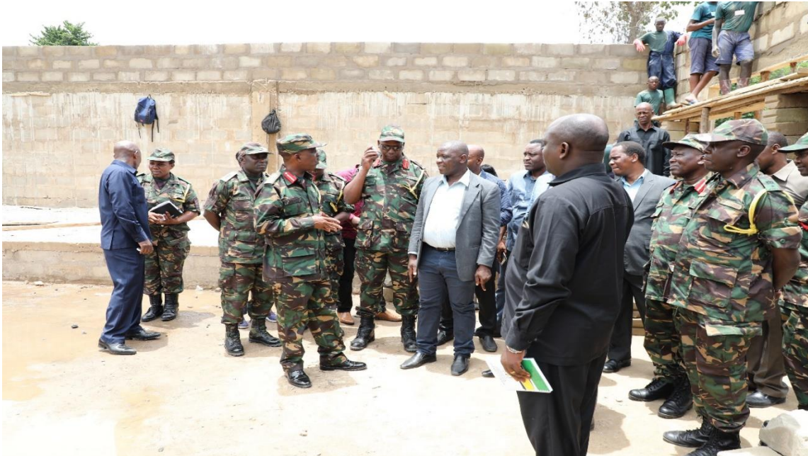
Kamati ya Kudumu ya Bunge ya Mambo ya Nje, Ulinzi na Usalama ilipotembelea Mradi wa ujenzi wa bwalo kwenye Kikosi kipya cha Jeshi 830 – Kibiti, Mkoa wa Pwani tarehe 15 Machi, 2020.
